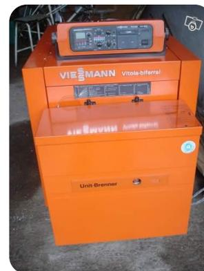
Je regarde dans un premier temps la pression d'eau d'installation, celle-ci est bonne (**1,2 bar**). Ce n'est pas un défaut brûleur, car celui n'est pas en sécurité. La chaudière fonctionne mais uniquement en marche forcée, donc un problème électrique est envisageable (régulation, sondes...)
